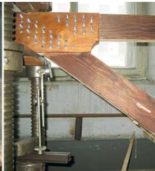
Рис. 4. Фотофиксация разрушения опорного подкоса
