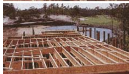
Рис. 1. Использование двутавровых деревянных балок в конструкции кровли
