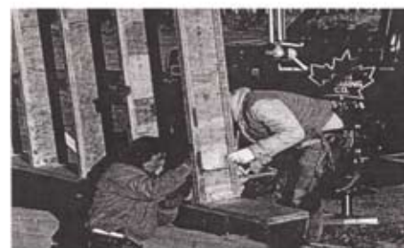
Рис. 2. Использование двутавровых деревянных балок в качестве стоек
